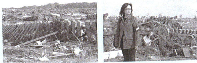
写真1 宮城県亘理郡巨理町・山元町と名取市の状況。線路の枕木が波に持ち上げられ、原形をとどめていない
